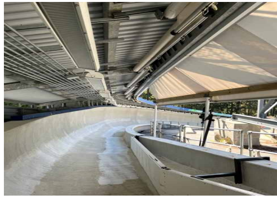
트랙(제빙작업 전 트랙 표면 유지보수 작업)
